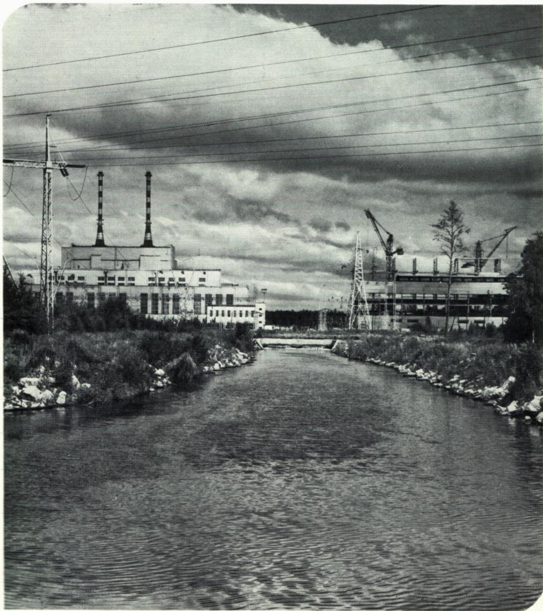
Водозаборный канал Белоярской АЭС им. И. В. Гурчатова.
